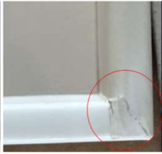
Фото 2. Недопустимое формирование стыка кромок в полотнах обратного открывания
